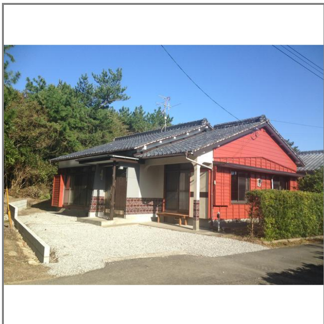
玄関前を整地して駐車スペースを広く確保しました。
